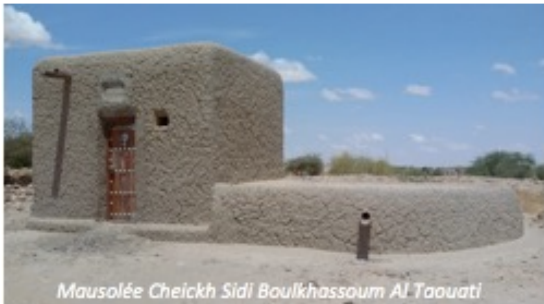
Mausolée à la fin de la rénovation.
