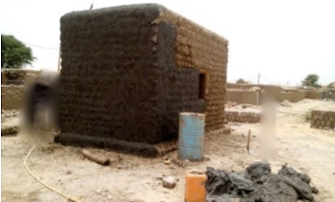
Mausolée Tamba-Tamba : la première couche d'enduit extérieur au mortier
