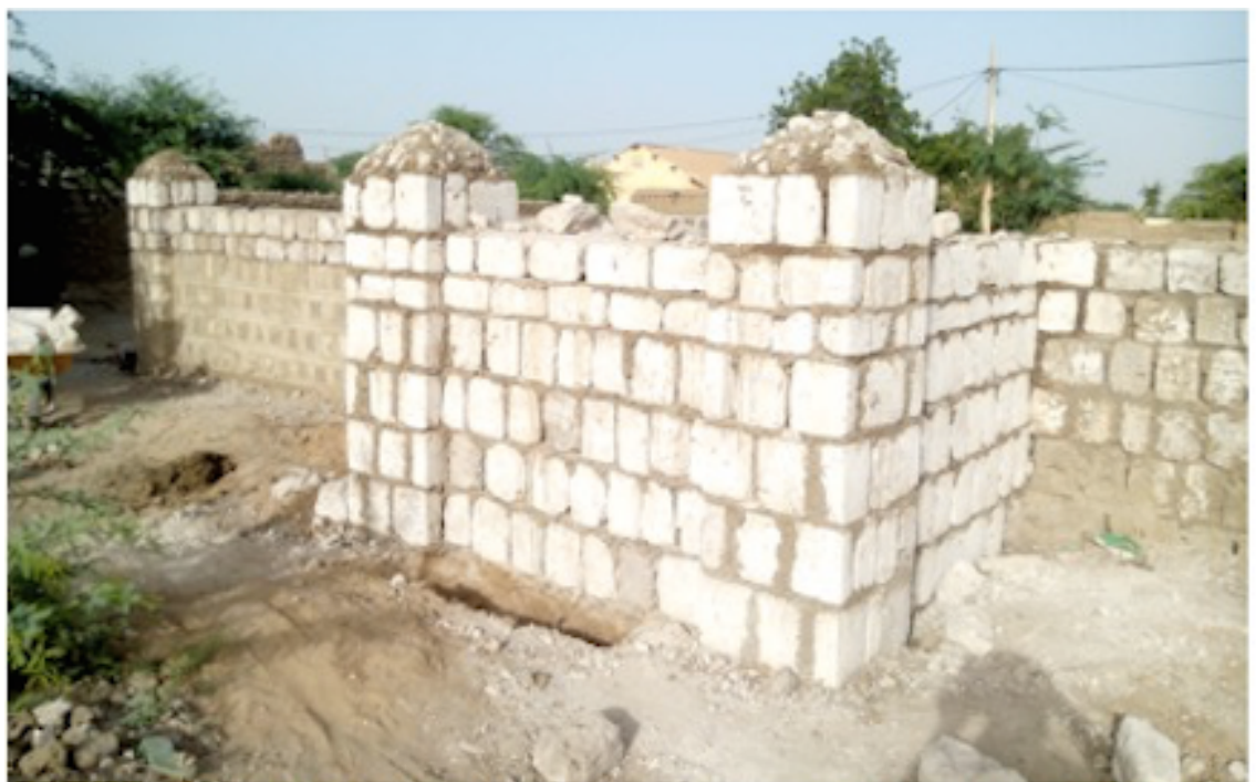
Mausolée Tamba-Tamba : Les poteaux raidisseurs aux angles, ici au niveau du minaret.
