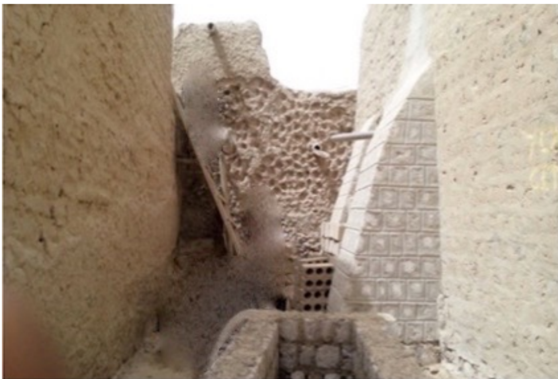
Mausolée Mahamane Askia : le début des travaux d'aménagement des bâtiments voisins.
