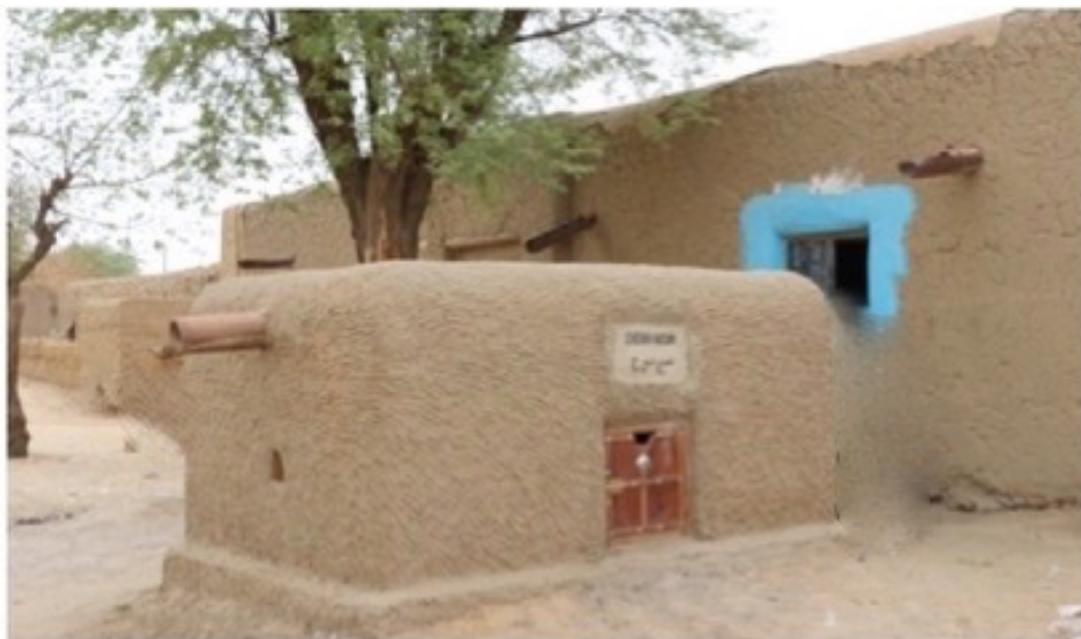
Le mausolée de Cheikh Nouh : le bâtiment fini ; la porte-fenêtre et la place d'identification posées.
