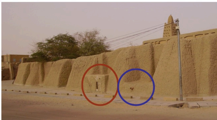
Mur ouest de la Mosquée de Diingarevber
