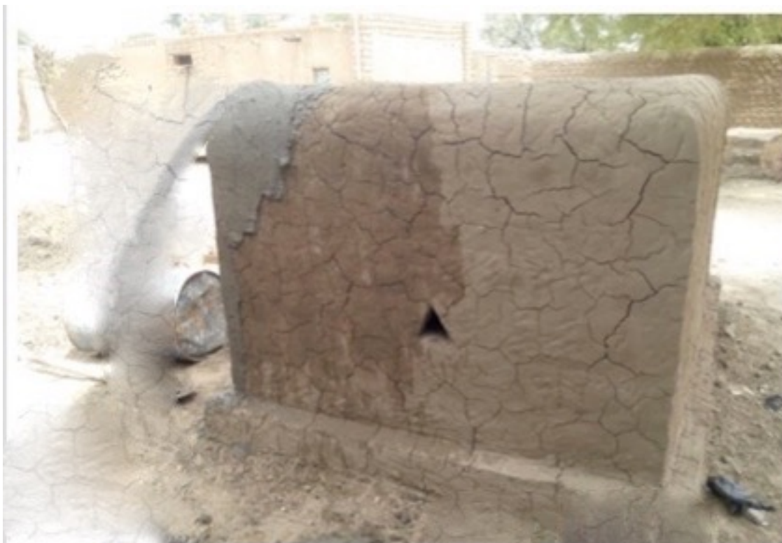
Le mausolée de Cheikh Nouh : La deuxième couche d'enduit extérieur au mortier de banco stabilisé avec de la paille de riz.
