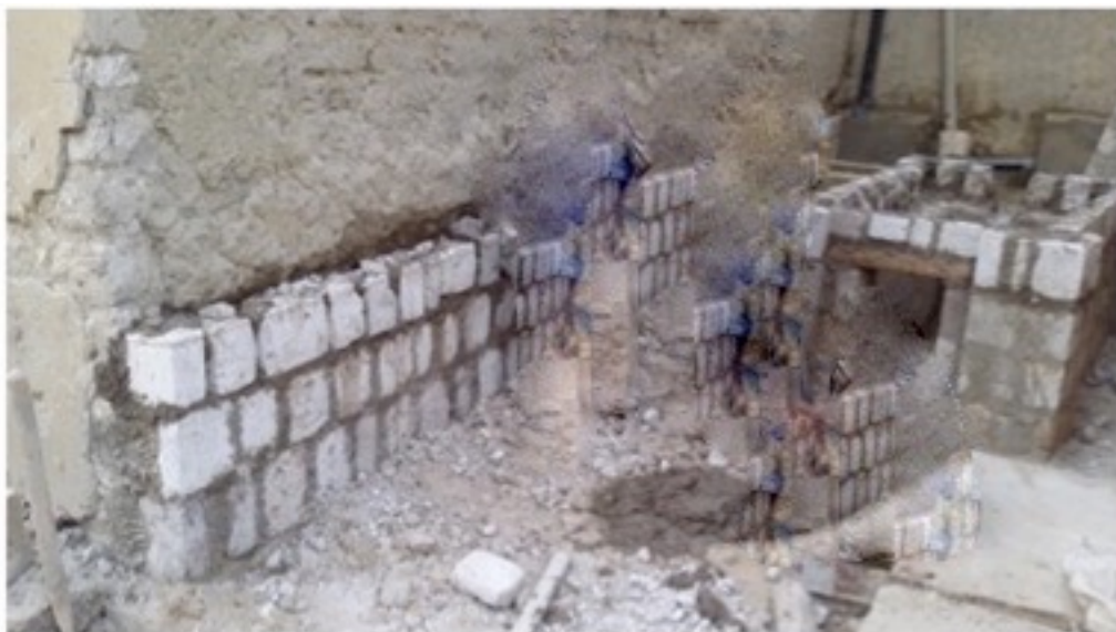
Mausolée Mahamane Askia : les travaux de renforcement de la base du mur voisin affecté par les eaux usées ;
