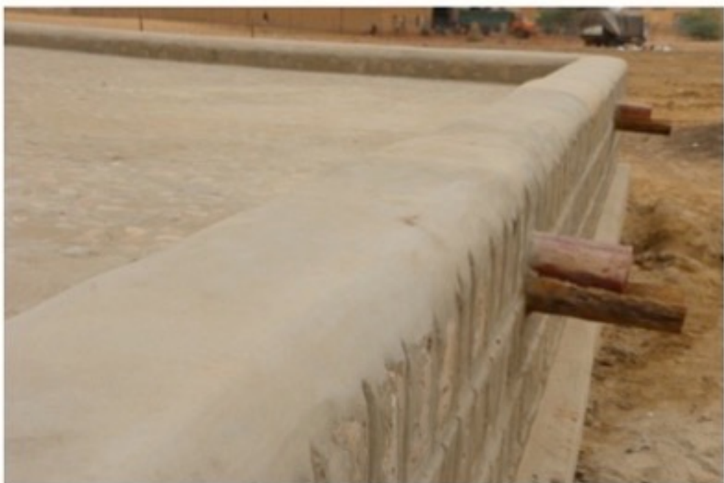
Mausolée Cheickh Ousmane El Kebir : Le remblai est damé et la terrasse est recouverte de carreaux de terre cuite jointoyés au mortier de ciment en barbotine.
