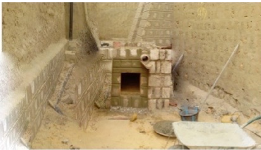
Mausolée Mahamane Askia : les travaux de finition sur le mausolée et sur l'aménagement.
