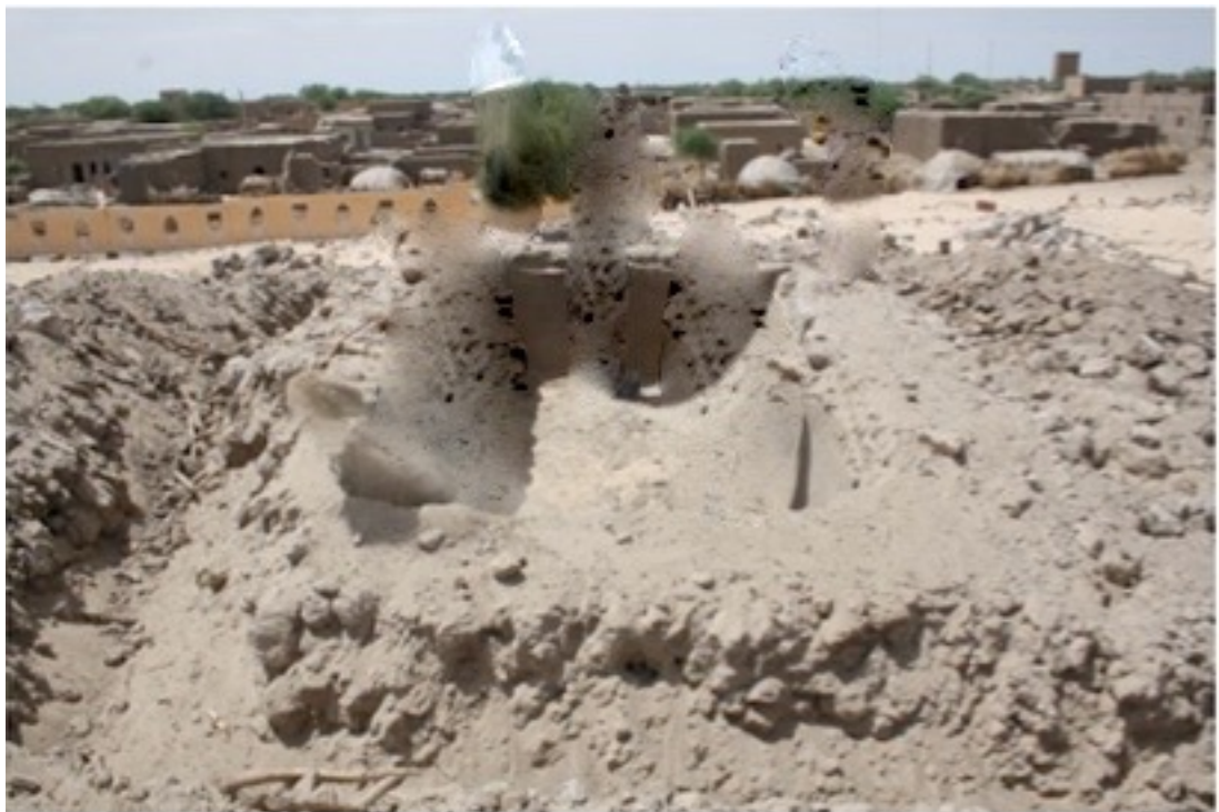
Mausolée en cours de rénovation.
