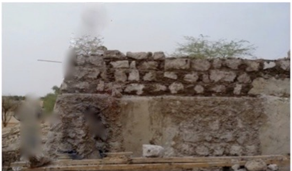
Mausolée Alpha Moya: les inclinaisons, les hauteurs et la nature des restes des murs conservés sont respectées par les nouvelles maçonneries.
