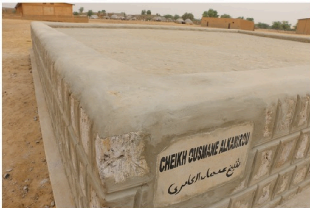
Mausolée Cheikh Ousmane El Kebir : Le soubassement (la botte) et le sommet du mur acrotère (le chapeau) sont traités au mortier de ciment pour une meilleure protection de l'édifice qui se trouve exposé.
