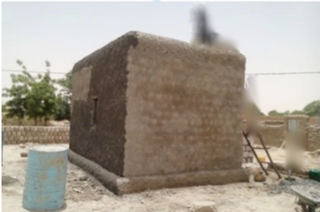
Mausolée Tamba-Tamba : la dernière couche d'enduit extérieur au mortier de banco avec la poudre de balle de riz exécuté à la manière sanfa-sanfa.
