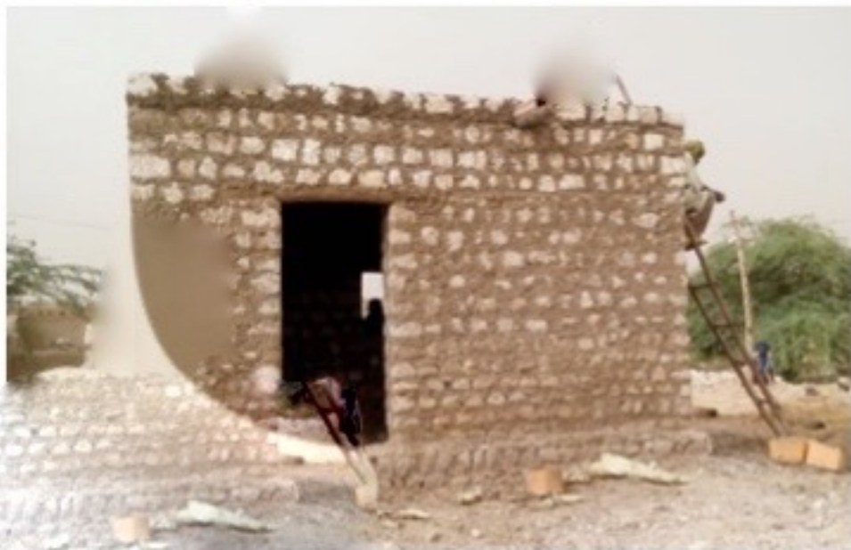
Mausolée Tamba-Tamba : Après la couverture, la pose des gargouilles et la construction de l'acrotère.
