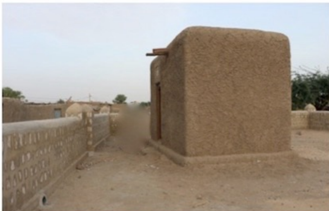
Mausolée Tamba-Tamba : le bâtiment fini et l'aire de prière clôturée.
