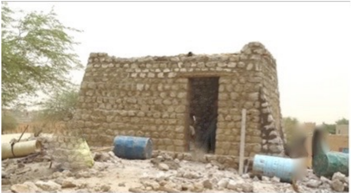
Mausolée Alpha Moya: le contrefort ponctuel a également été reconduit.
