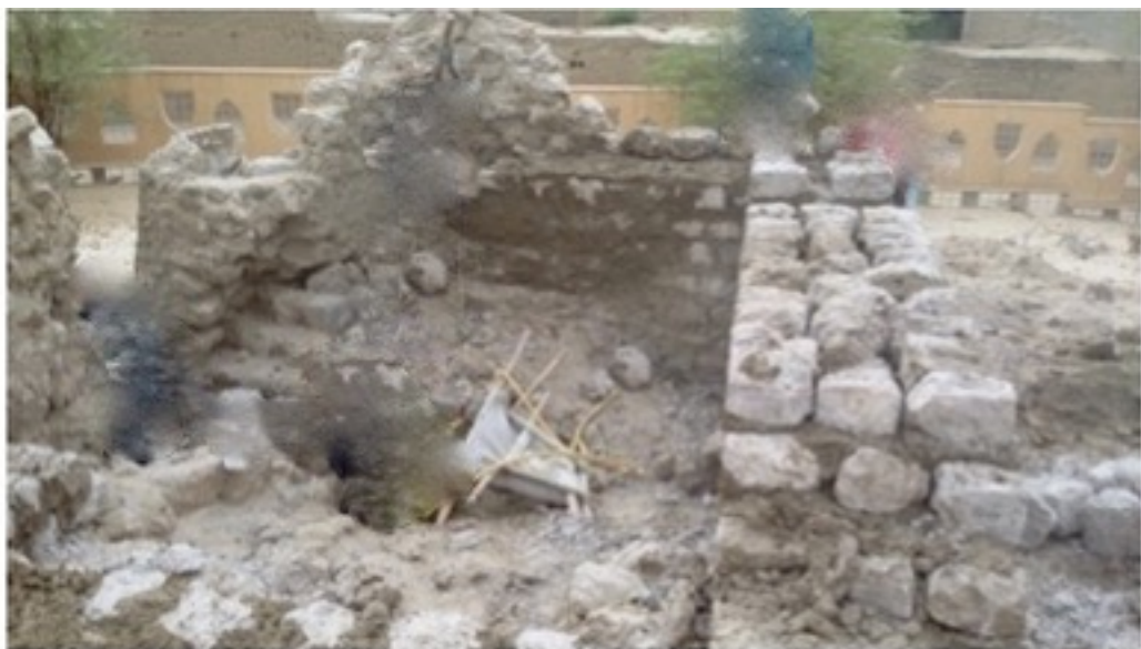
Mausolée Alpha Moya: les maçonneries des anciens et des nouveaux murs s'intègrent sur des plans en cascade (verticalement et horizontalement)
