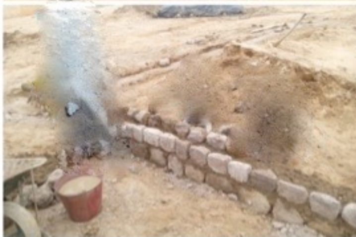
Mausolée Cheickh Ousmane El Kebir : Les maçonneries de murs de fondation et de soubassement.
