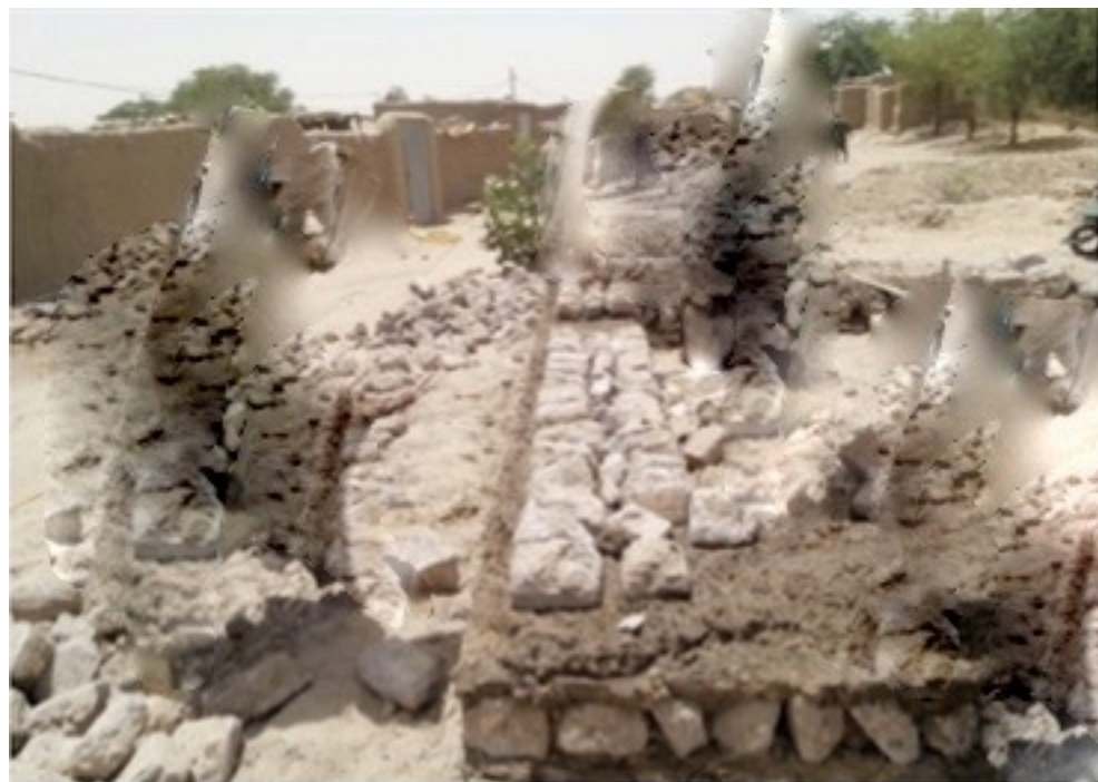
Mausolée Tamba-Tamba : la maçonnerie de pierres alhore hourdées au mortier de banco pour le soubassement...
