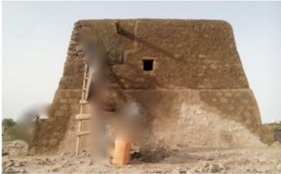
Mausolée Alpha Moya: travaux de crépissage : pose de la première couche en mortier de banco stabilisé avec de la paille de riz
