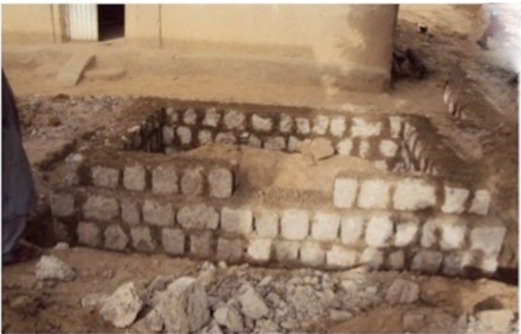
Le mausolée Cheickh Mohammad Al Fullani Al Macina : les maçonneries des murs en fondation, en soubassement et en élévation, en pierres alhore au mortier de banco.
