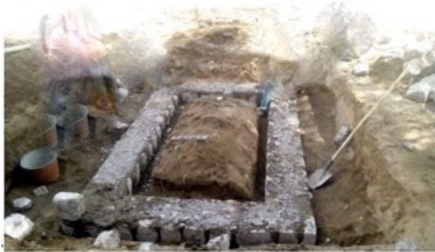
Le mausolée de Cheikh Nouh : L'implantation et la construction du mur de fondation en maçonnerie de pierres aihore et de mortier de banco.
