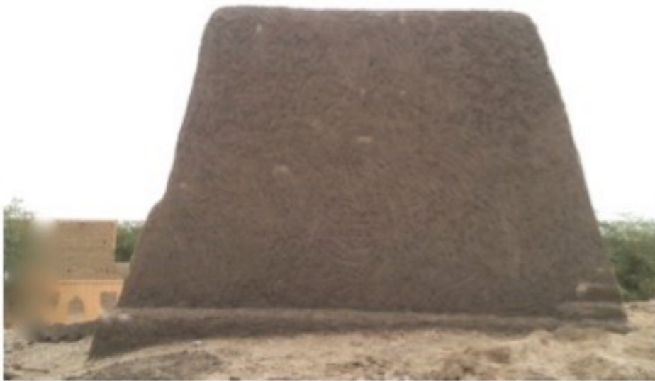
Mausolée Alpha Moya: La couche finale de l'enduit au mortier de banco stabilisé avec la poudre de balle de riz et appliquée à la manière sanfa-sanfa.
